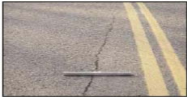
Longitudinal Cracks
