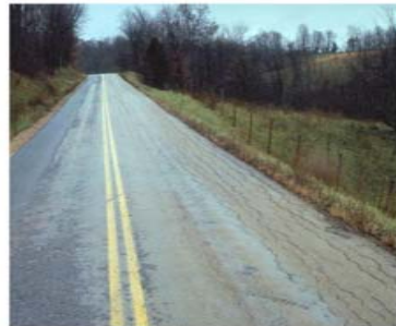
Edge Cracks
