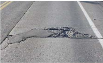
Spalling
